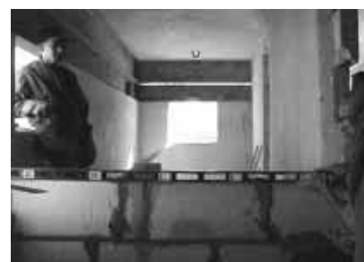
Verificação do alinhamento e prumo
