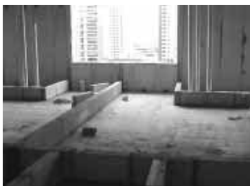
Foto da locação – 1ª fiada
