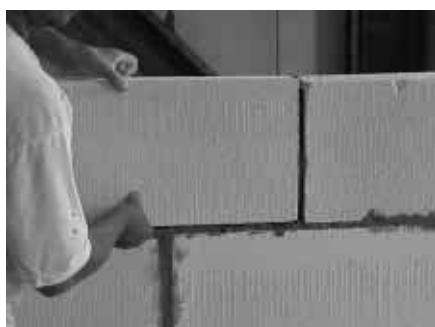
Juntas horizontais preenchidas
