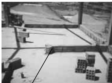
Alvenaria 1ª fiada
